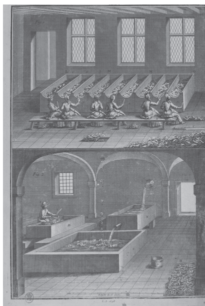
Fig. 6 – Tanques e triagem (Planche I, fig. 3) LALANDE, Jérôme de Art de faire le papier. Paris, Saillant et Nyon, 1761 Fonte: gallica.bnf.fr/Bibliothèque nationale de France
